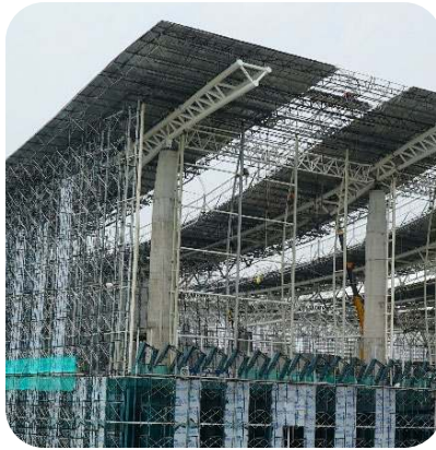
2-coat Epoxy PU System
