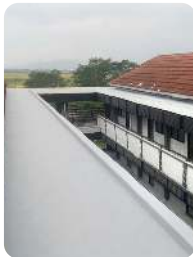
Dak Beton Ruko
