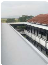
Dak Beton Ruko
